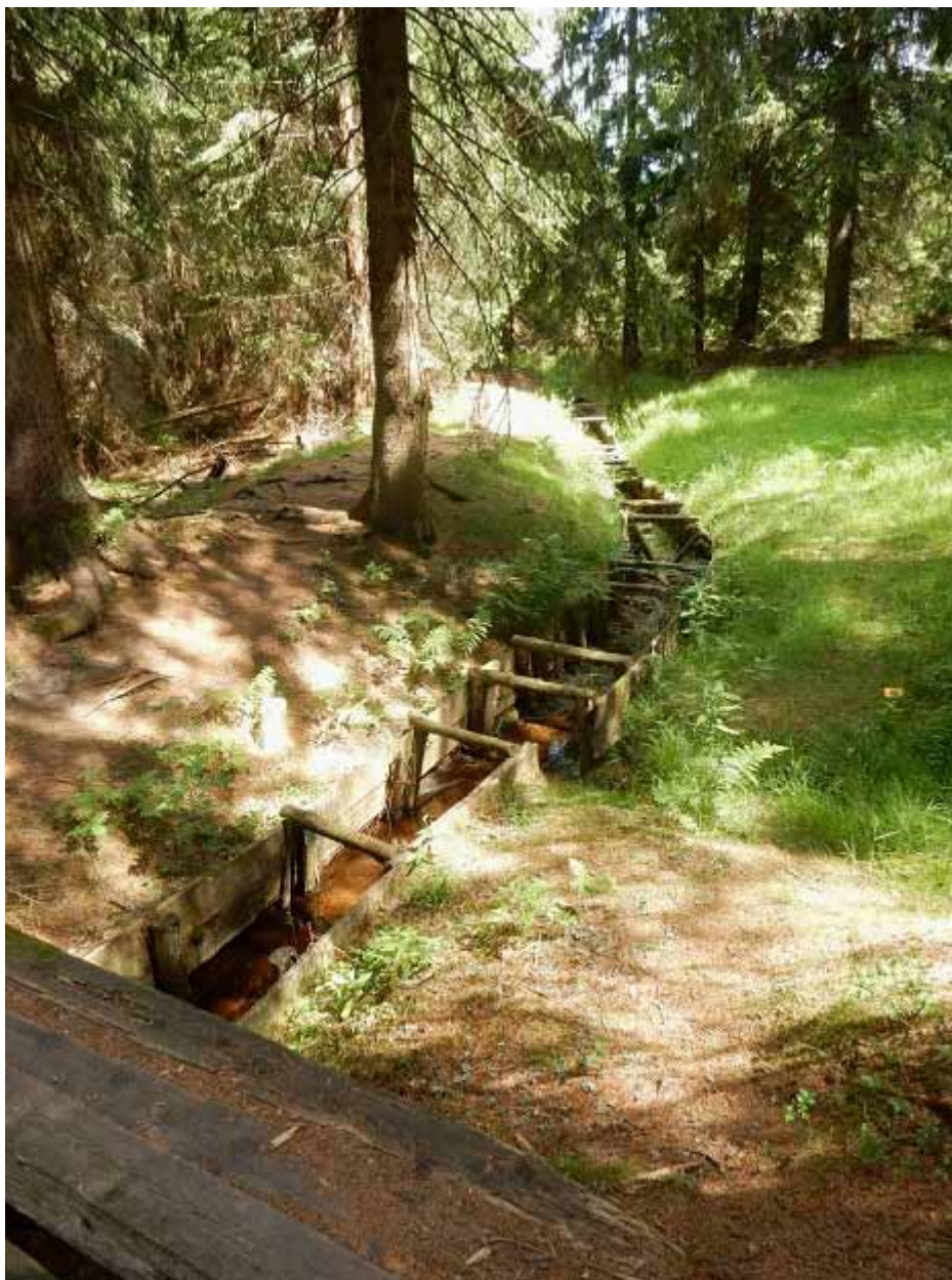
Obr. 6: Blatenský příkop u křížení NS Blatenský příkop se silnicí Skákavá. Koryto zpevněno bedněním
